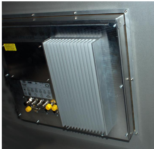
Aufsetzen des Montagerahmens
